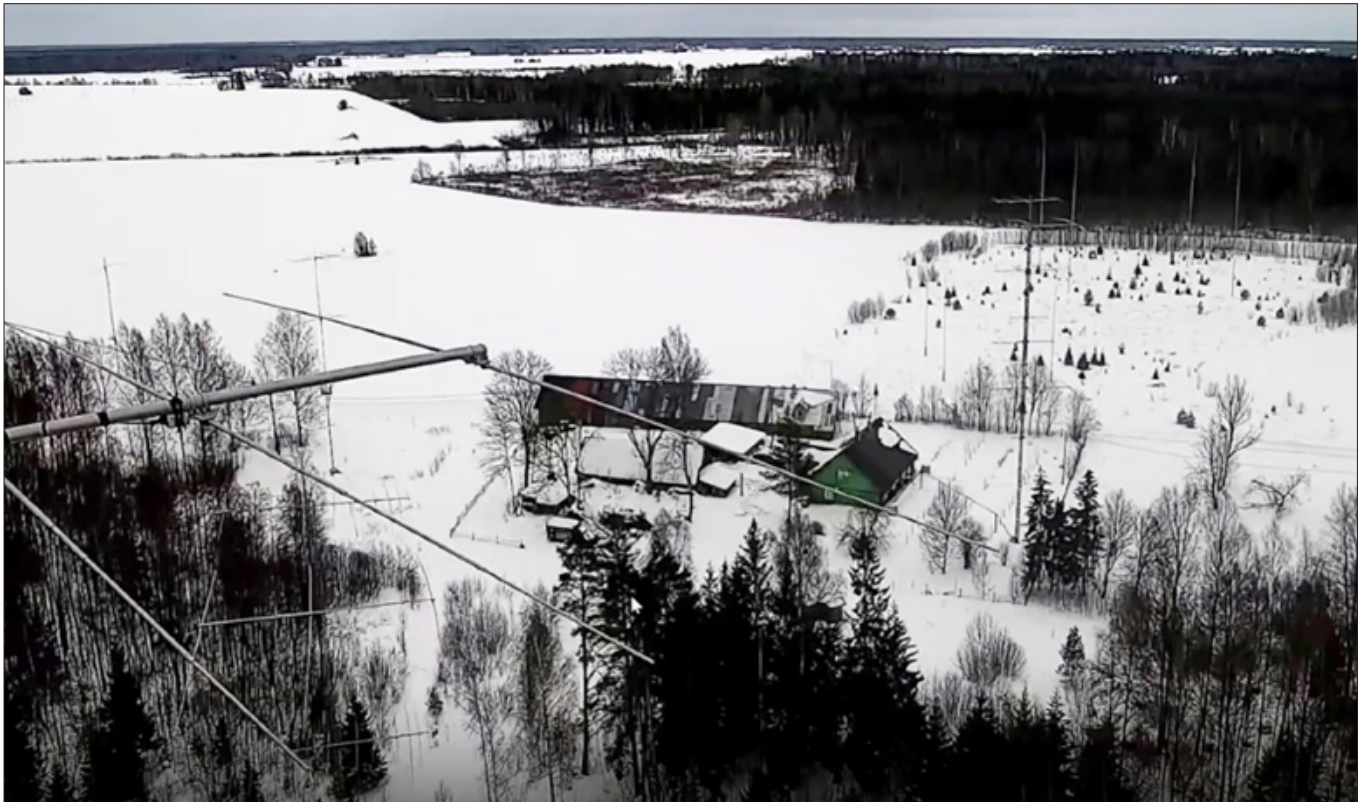
Reaalajas vaade ES5TV suure torni tipust Jõgevamaal
